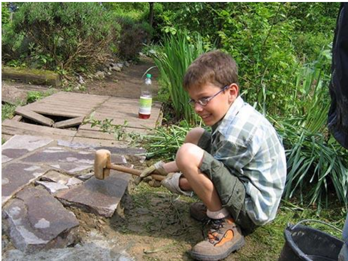
26. Pflasterarbeiten mit heimischem Sandstein
